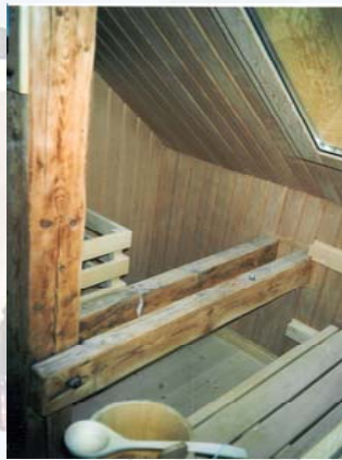
Saunakabine in Hemlock im Dachgeschoss mit integriertem Dachfenster
