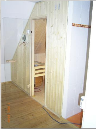
Saunakabine in Hemlock im Keller- gewölbe mit Bogendecke und integriertem Kellerfenster
