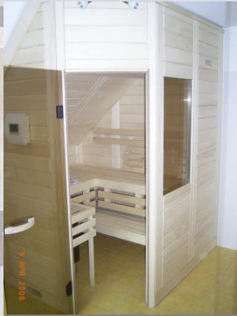
Eckkabine in Fichte an Dach - schräge angepasst
